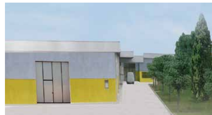
▲ Sede principale di Viadana
